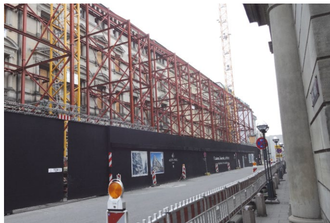
Bild 2 Frontfassade mit temporären Gerüsten Front facade with temporary scaffold
