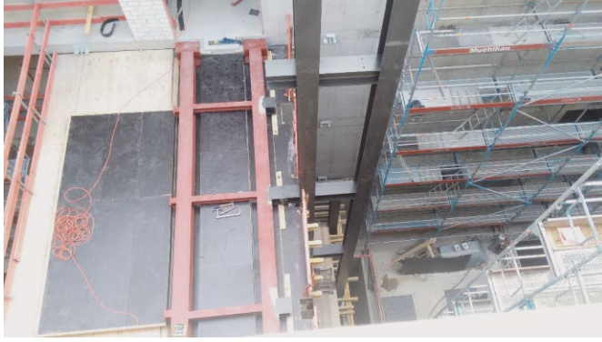
Bild 8 Aufzugsgerüst mit angeschlossener Verbundbrückenunterkonstruktion Lift construction with connecting composite construction
